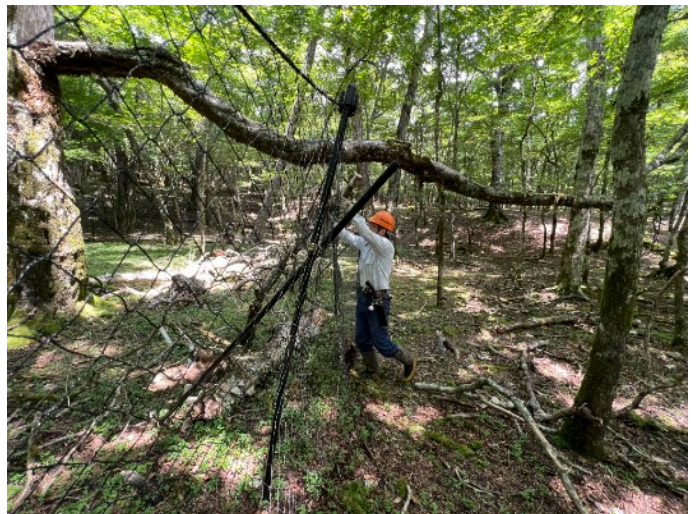
植生保護柵の修理
