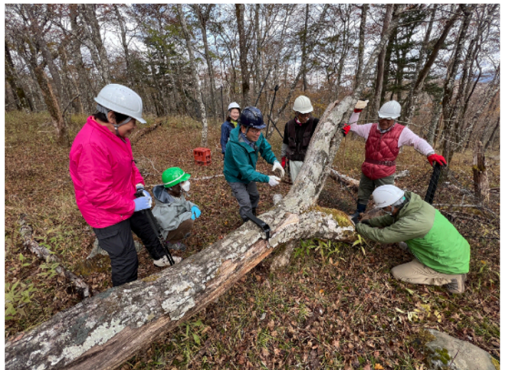
植生保護柵の修理
