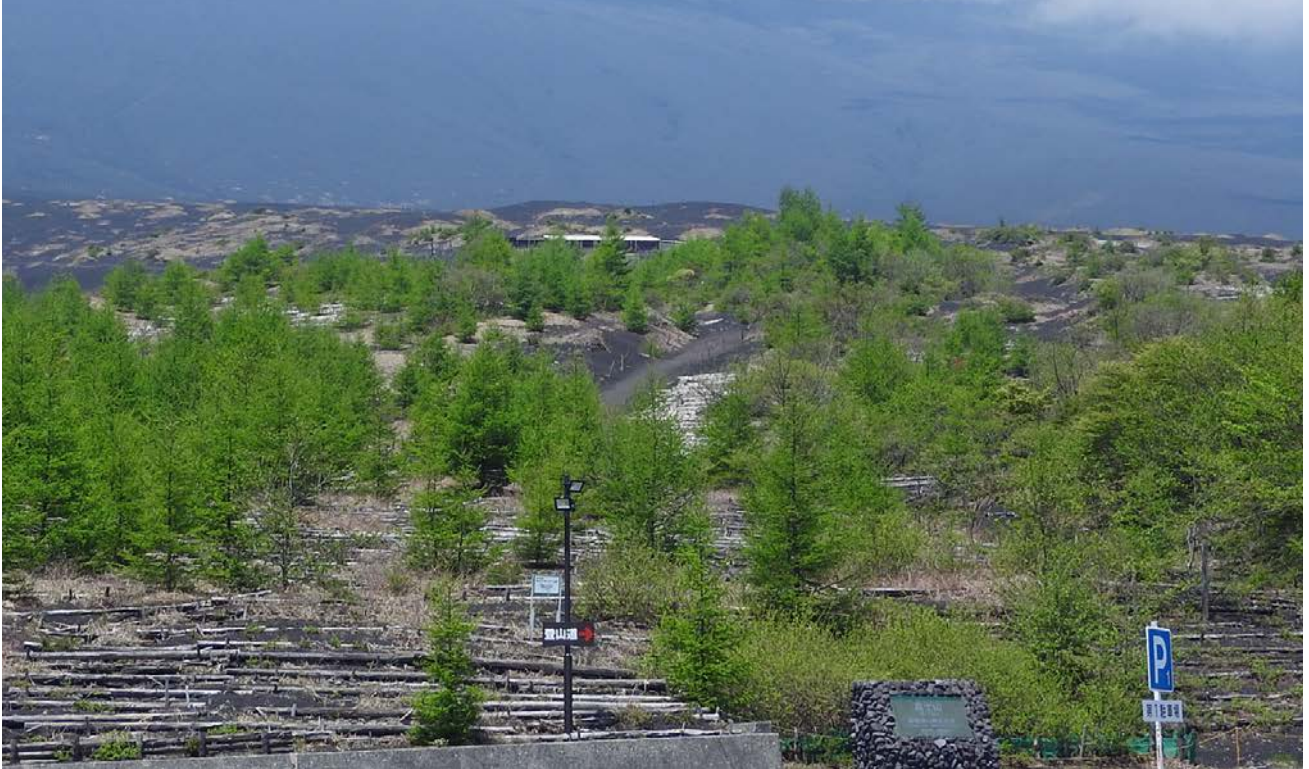
土止めとミヤマヤナギが植栽された斜面にはカラマツが自生し成長している (2017年撮影)
